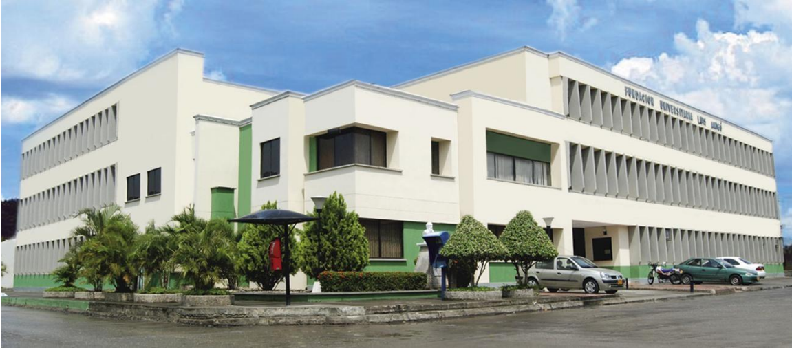
Ilustración 15. Centro Regional Montería
