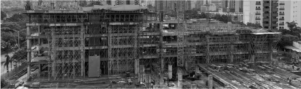
Foto 4 Vista estructura torre 1
