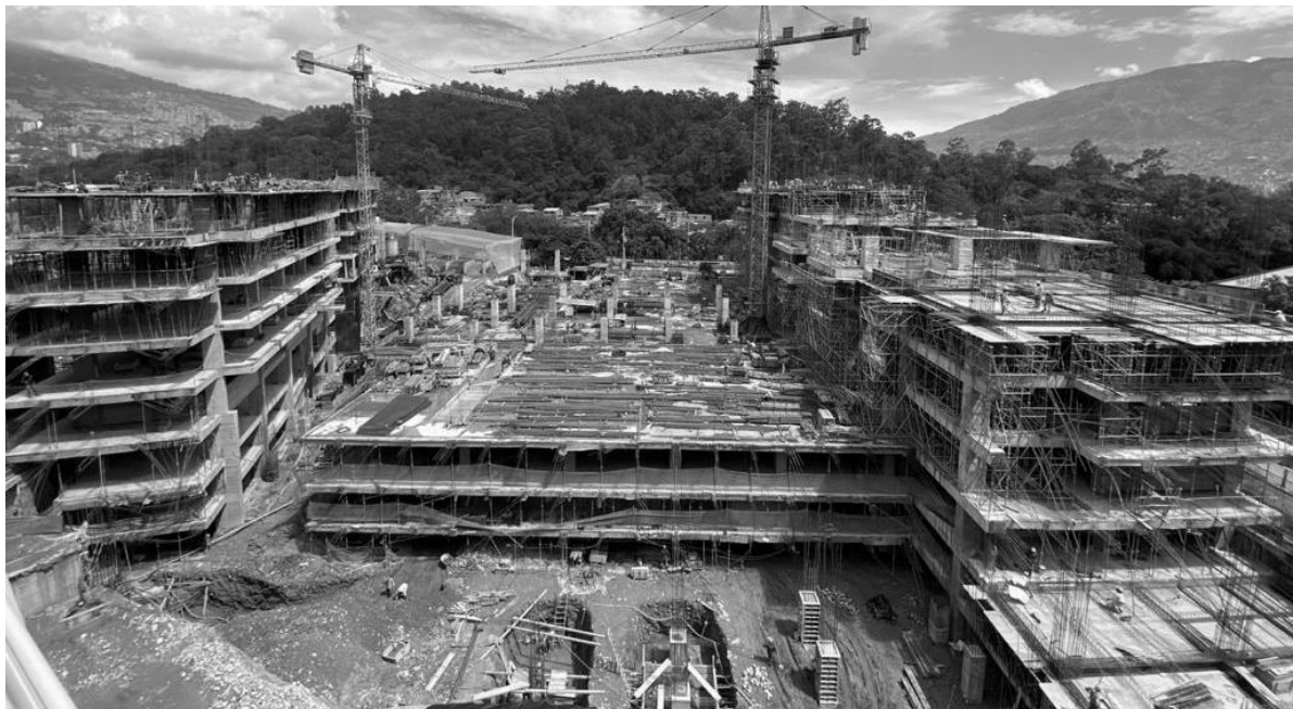
Foto 1 Estado General de la Obra a noviembre 18 de 2020
