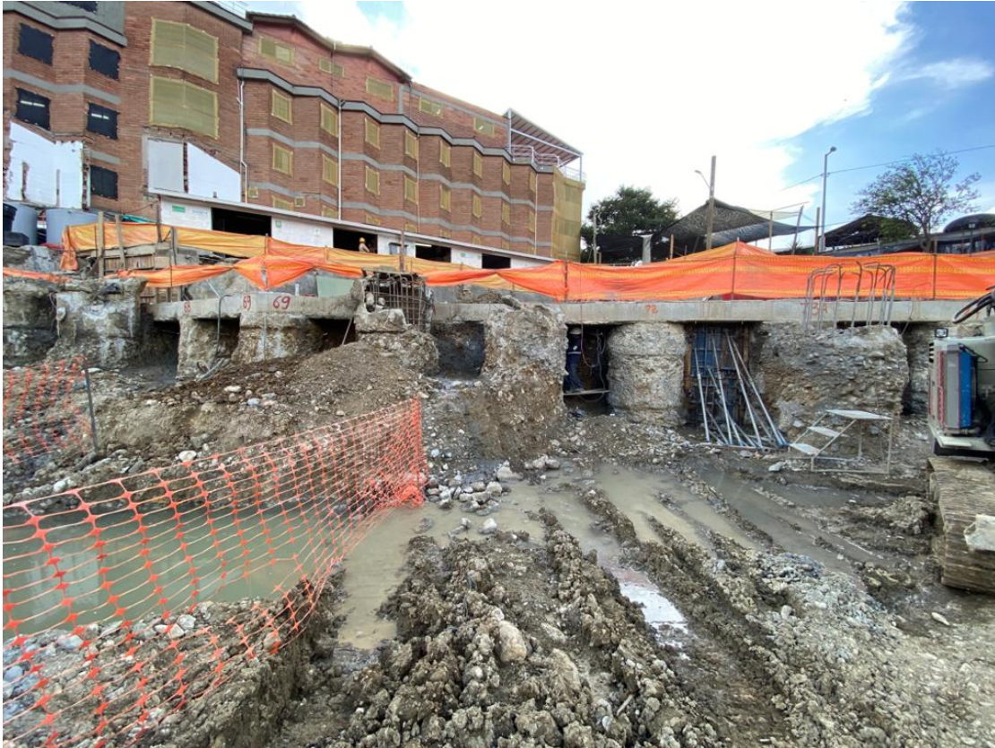
Foto 3. Vaciado de muro tabique entre pilas de contención torre 2
