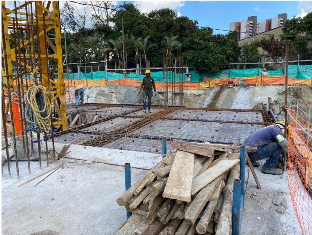
Foto 2. Excavación Berma Superior Torre 1
